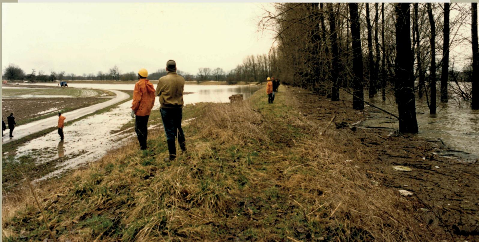
Auf der Innenseite des Dammes ist in ca. 15 m Breite der Damm abgesackt und von oben her eingebrochen. Die Helfer sind links und rechts auf dem Damm zurückgelaufen um die Autos aus dem Überflutungsgebiet herauszufahren. Jetzt ist nichts mehr aufzuhalten. In der Bildmitte ein Anhänger mit Sandsäcken beladen. Dieser gehört Josef Neubauer, er hat abgehängt und ist mit Volldampf nach Niederachdorf um die schlimme Nachricht zu überbringen.
