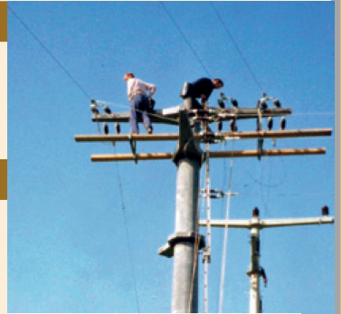
Leitungsbau in den 1990-er Jahren E-Werk Heider
