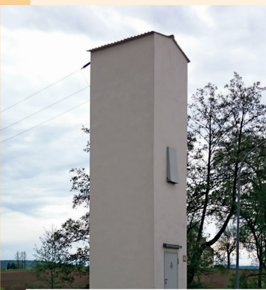
Trafostation in der Birkenstraße in Oberzeitldorn 2017
