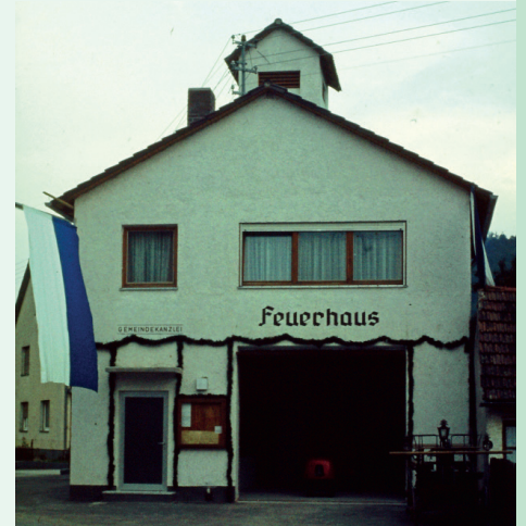
Gemeindekanzlei und Feuerlöschhaus Pillnach (heute Waldstraße 4) 1971
