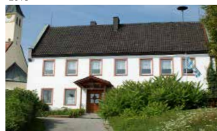
Schulungsraum der Feuerwehr Obermiethnach, Petersweg 13 2014
