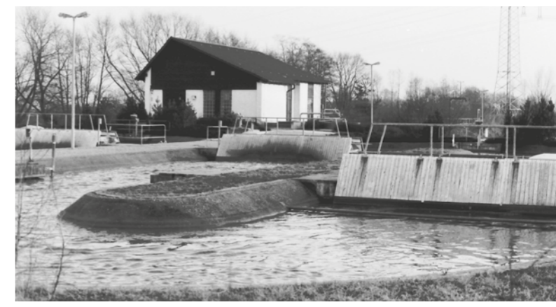
1981 Neubau der Kläranlage Bachhof 8
