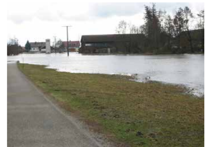
2006 Überschwemmung Pillnach, Waldstraße
