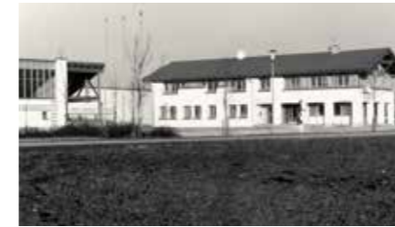
Seit 1986 befindet sich das Rathaus in der Regensburger Straße 22
