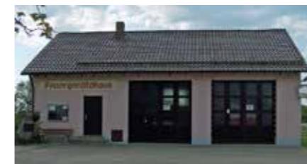
Feuerwehrgerätehaus Kirchroth bis 2011 in der Feuerhausstraße 1 2008
