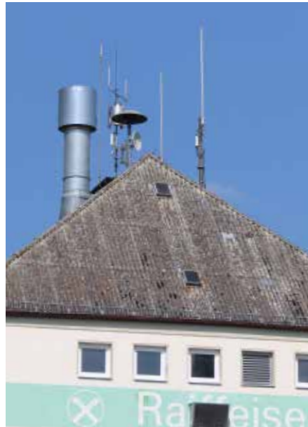
Mobilfunkanlage (D2) Pondorf 2018
