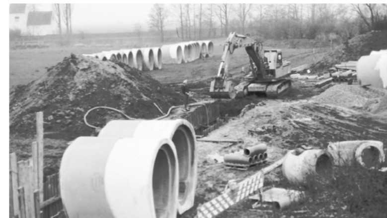
Bau des Stauraumkanals Kößnach 1984 im Bereich des Bolzplatzes
