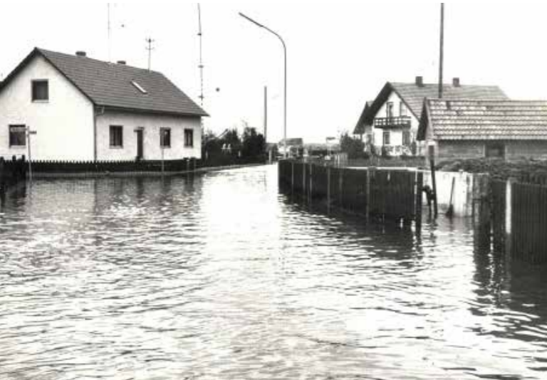
Das hochwassergefährdete Aufroth 1980
