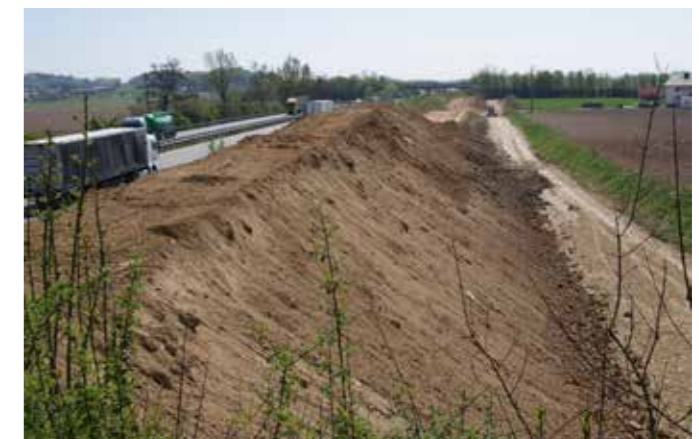
Bau Lärmschutzwall Thalstetten 2009-lfd. 2010
