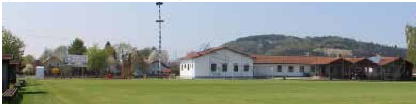
Sport- und Schützenheim Obermiethnach in Untermiethnach 18 a 2018
