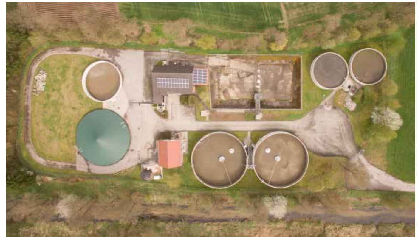
Drohnenaufnahme der Kläranlage Bachhof 8 Albert Kitzinger III 2018
