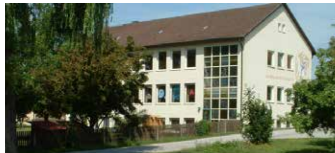
1983-2004: Der Kindergarten „St. Martin“ Kirchroth, Ortsplatz 28 im ehemaligen Schulgebäude 2004
