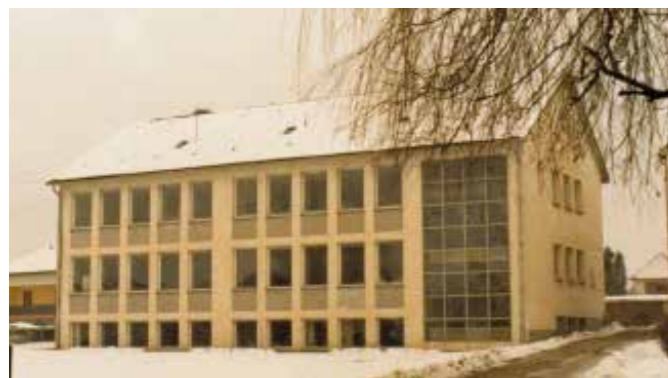
Schulhaus Kirchroth, Ortsplatz 28 Bau 1963, Nutzung bis 1982, Abbruch 2004, bis dahin als Kindergarten und Jugendheim genutzt; Heute steht dort die Kindertagesstätte 1980
