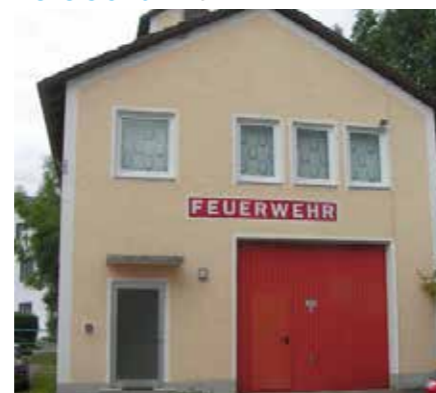
Feuerwehrgerätehaus Pillnach, Waldstraße 4 2017 Sigrun Kraus
