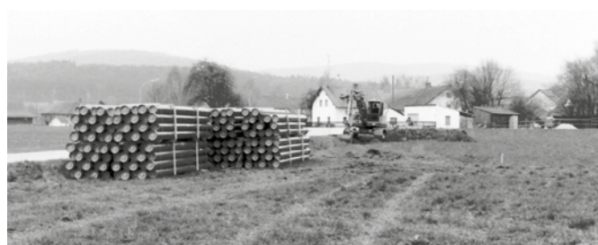
Wasserverbindungsleitungsbau von Thalstetten nach Aufroth 1987
