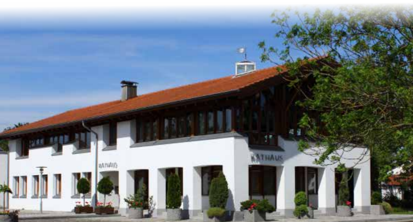
1986 wurde das Rathaus mit Bauhof Regensburger Straße 22, Kirchroth bezogen 2014
