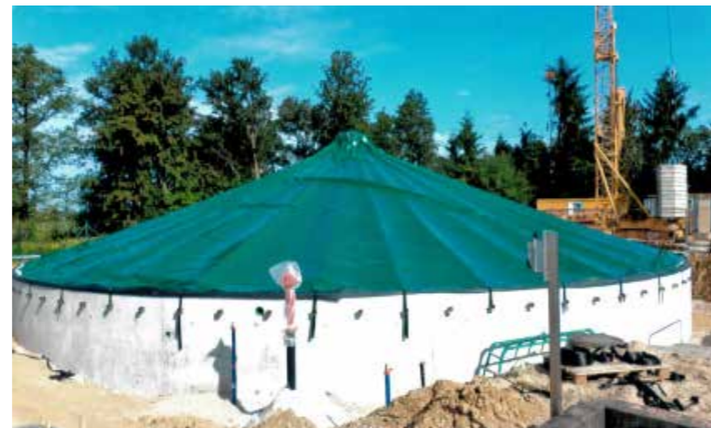
Kläranlage: Erneuerung Ausgleichsbecken und Vorlagebecken 2014
