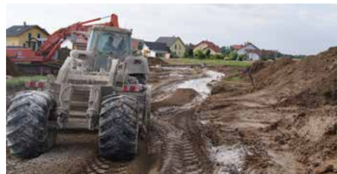
Erschließungsarbeiten Baugebiet Rother Feld, Aufroth 2010
