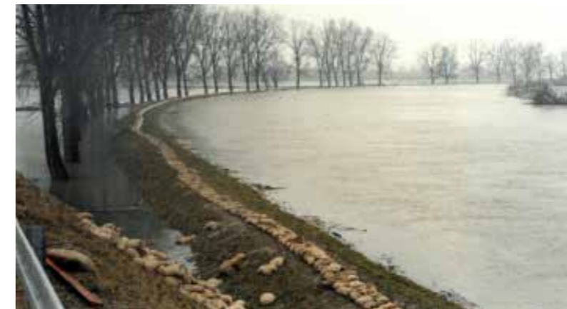
Dammstützungsmaßnahmen Christoph Kiefl
