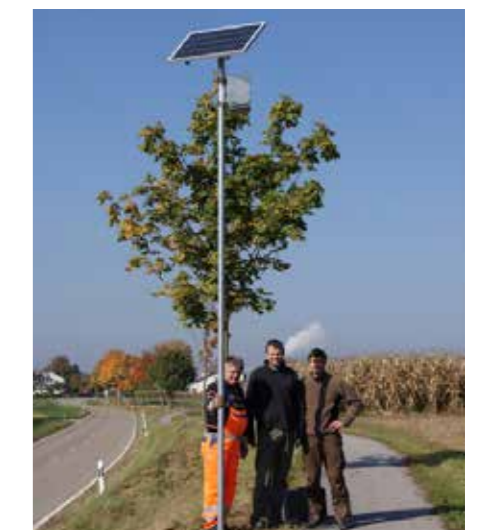
Solarleuchten für Geh- und Radweg Pondorf-Oberzeitldorn 2012
