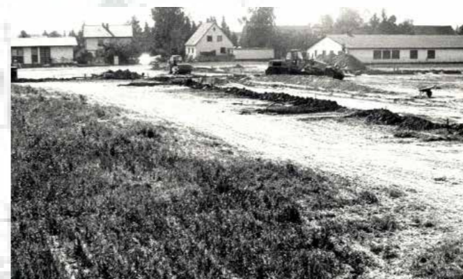
Erschließungsarbeiten Baugebiet Kapellenfeld BA I, Kirchroth 1982
