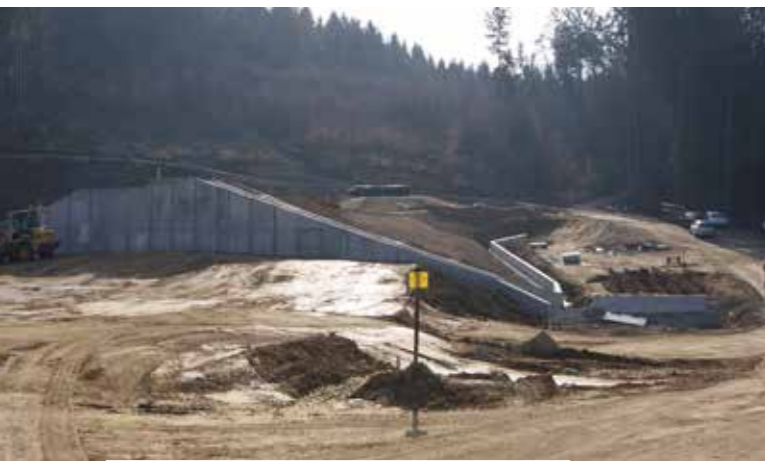
Baustelle Rückhaltebecken Aufroth 2012
