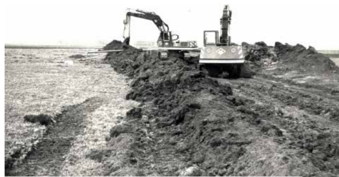
Wasserleitungsbau von Kößnach nach Pittrich 1980
