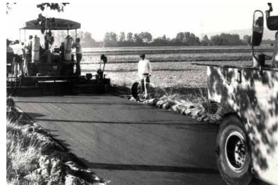
Asphaltierungsarbeiten für Gemeindeverbindungsstraße Weiher-Pittrich 1985
