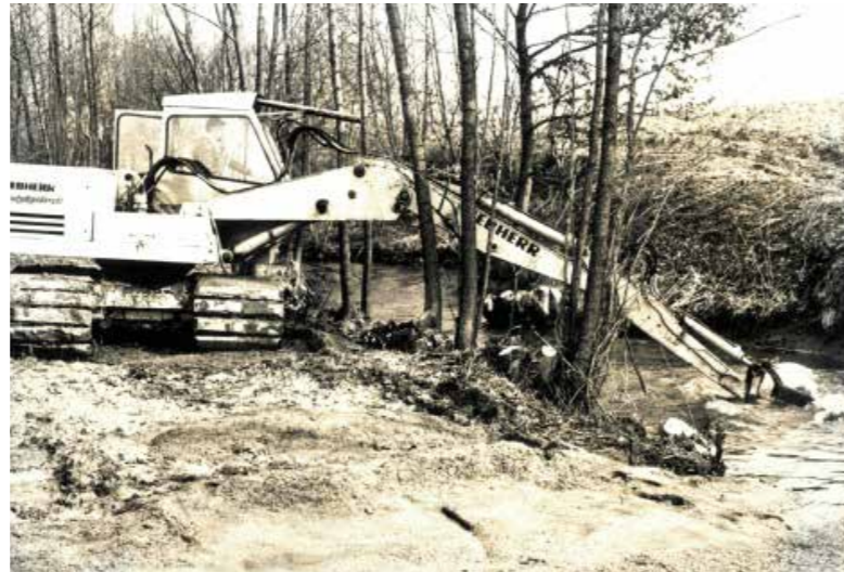
Räumung der Kößnach 1982
