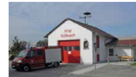
Feuerwehrgerätehaus Kößnach, Kirchgasse 1 FFW Kößnach
