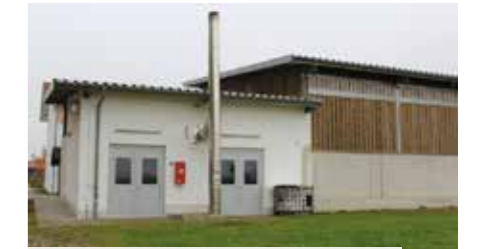
2010 erfolgte der Neubau einer Biomasseheizanlage 2017
