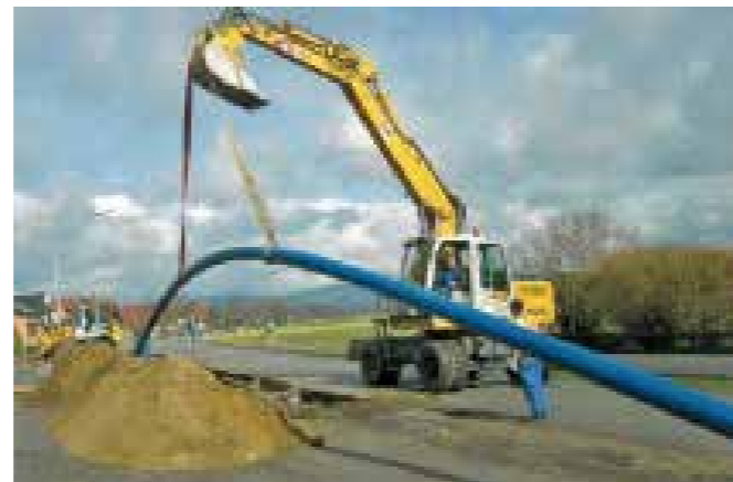
Erneuerung Wasserleitungen in Kößnach 2009 Broschüre „50 Jahre Zweckverband zur Wasserversorgung der Buchberggruppe“
