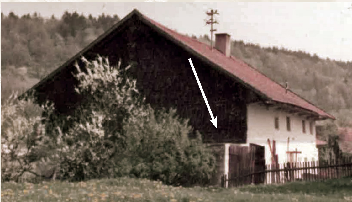
vor 1980: Links am Haus erkennt man die Grundmauern der ehemaligen Mühle Privatarchiv Manfred Reiter
