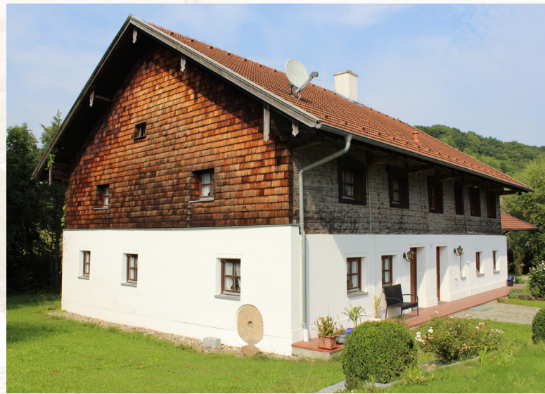
2017: Bei der Grundrenovierung des Hofes 1983 wurde der Mühlstein in der Hauswand freigelegt
