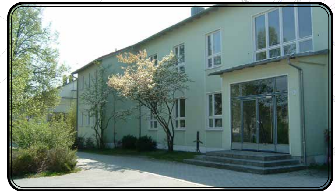
Fassade Pondorfer Schulhaus
