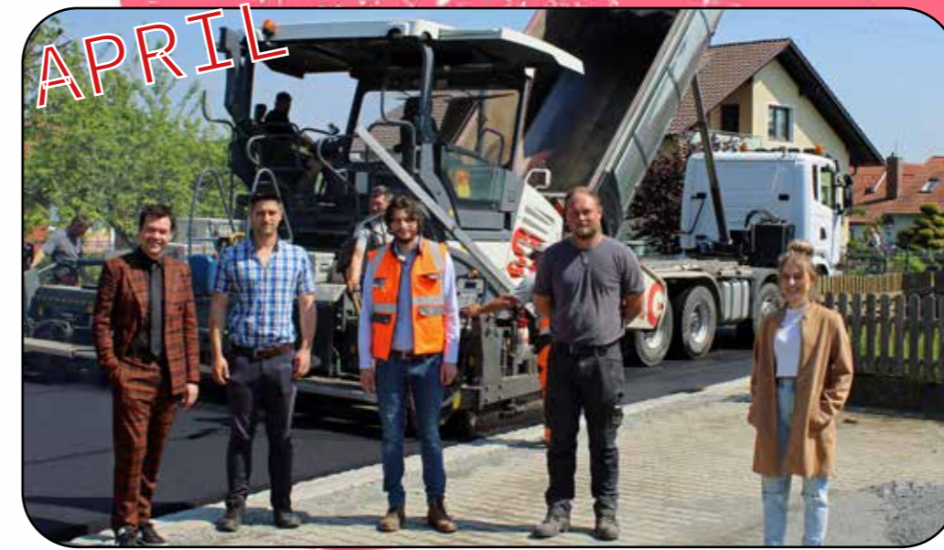
Sanierung „Zur Fähre“, Niederachdorf
