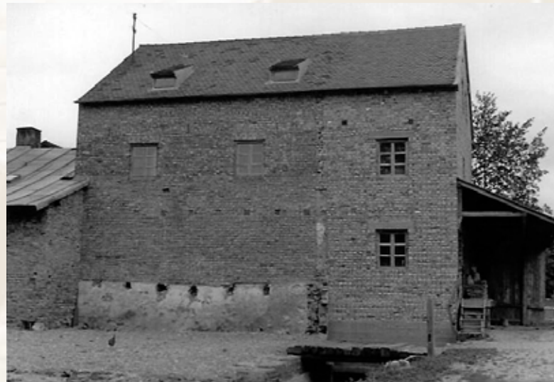
ca. 1956: Die Ostseite nach dem Einbau einer Turbine und der Mühlenerweiterung 1952 Privatarchiv Franz Schmerbeck
