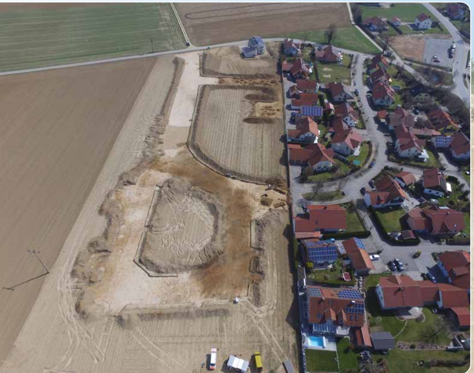
Luftbild des aktuellen Baugebiets mit bereits freigelegten Erschließungsstraßen
