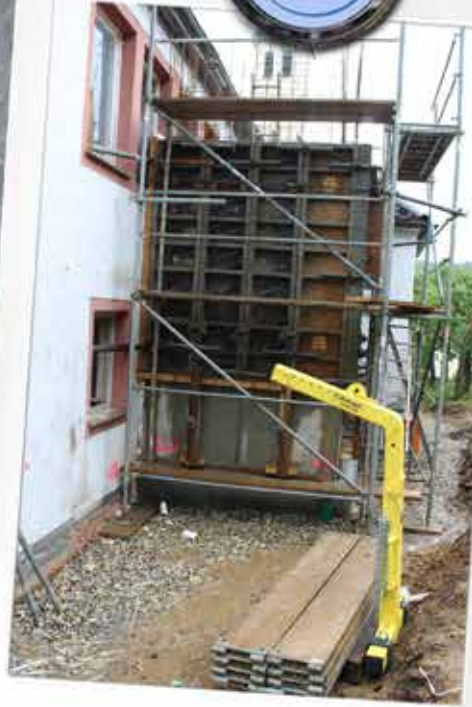
Anbau des Aufzugs
