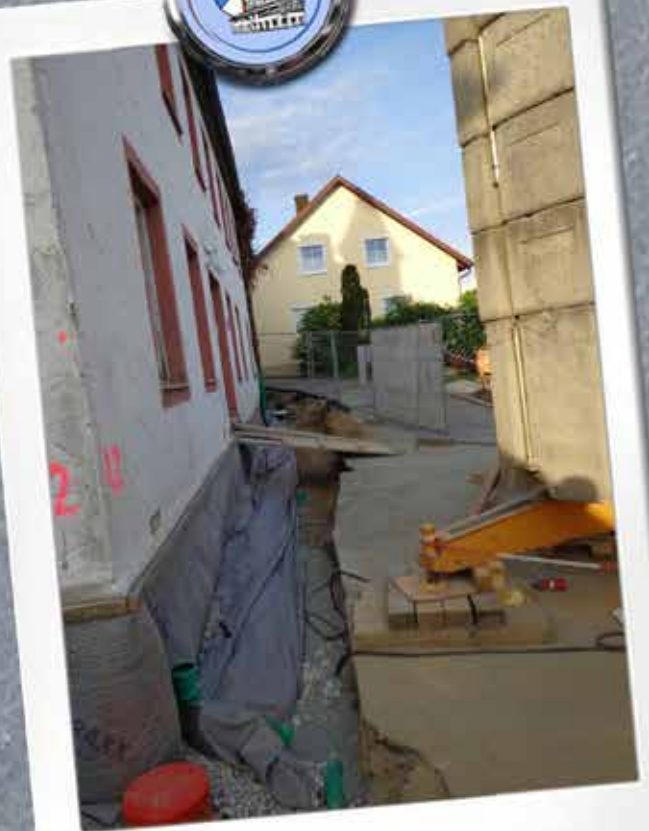
Abdichten des Gebäudes
