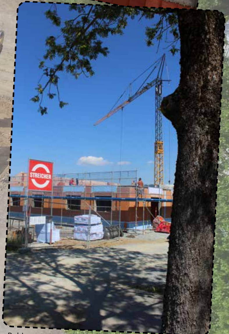
Rohbau Fa. Streicher, Deggendorf
