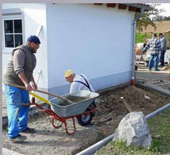
Pflasterarbeiten am neuen Zugangsbereich
