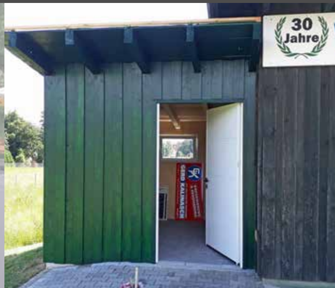
Neuer Geräteschuppen nach Fertigstellung
