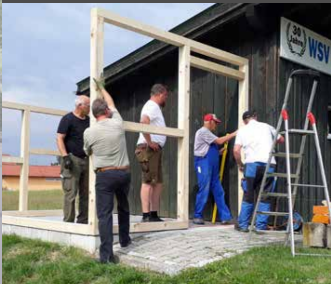
Rohbau des neuen Geräteschuppens
